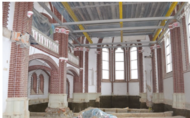
Wzmocnienie konstrukcji kościoła. ARKADA
